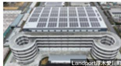
Landport厚木愛川町
